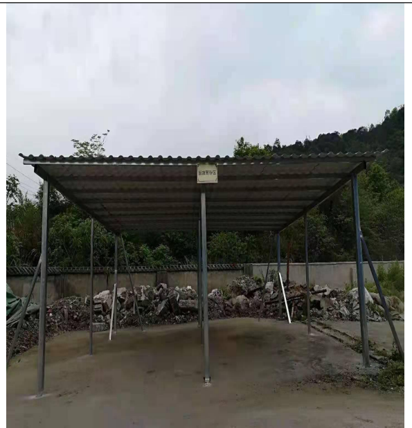
一般固废堆场
