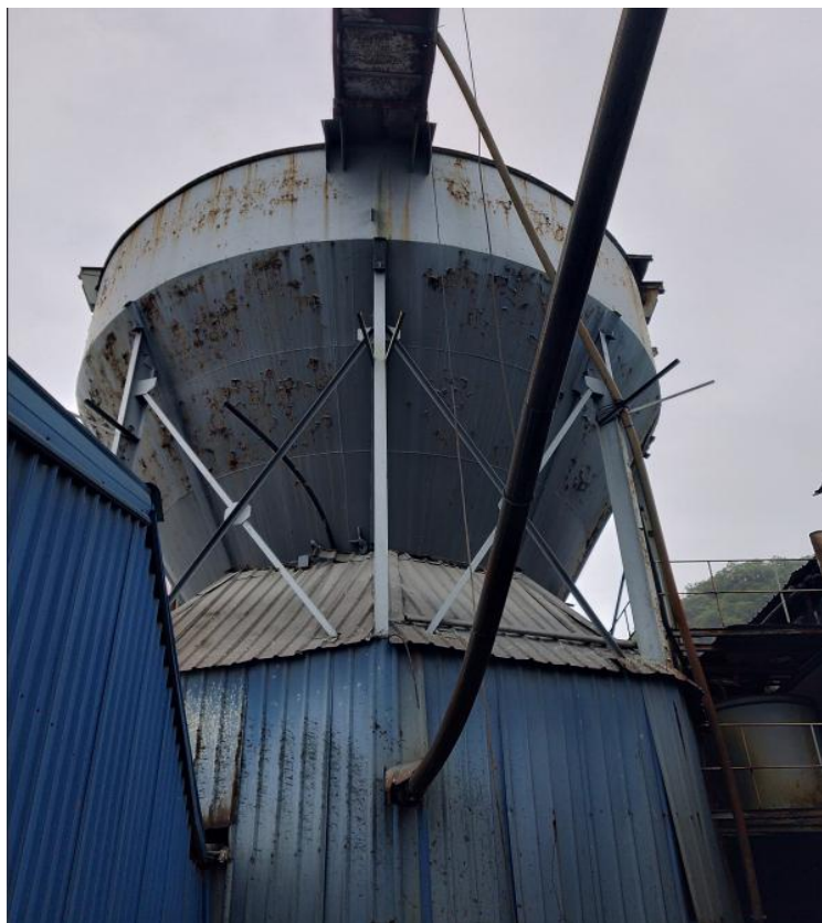
图 4.1.2-3 选矿车间高位水池
