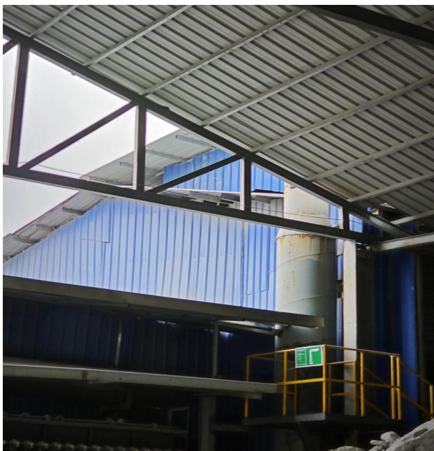
图 9.6-1 废气排放口标识牌
